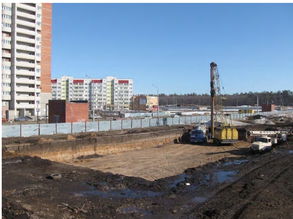
Рис. 1. Общий вид участка, предназначенного под застройку сооружения.
