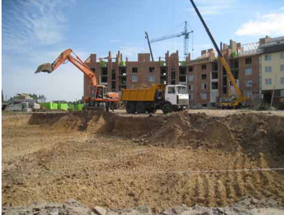
Рис. 1. Общий вид участка, предназначенного под застройку сооружения, в стесненных городских условиях.
