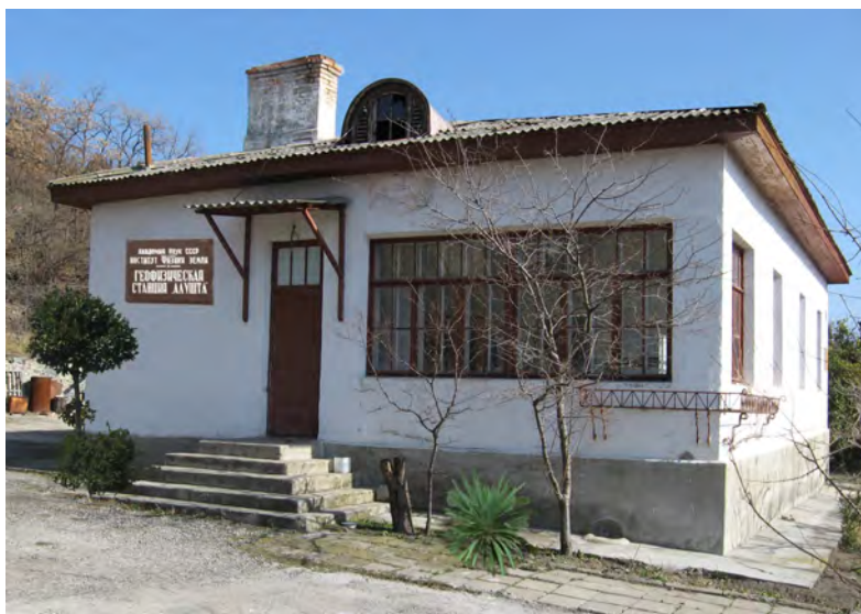
Рис. 1. Геофизическая станция «Алушта». Здание построено в 1957 г.
