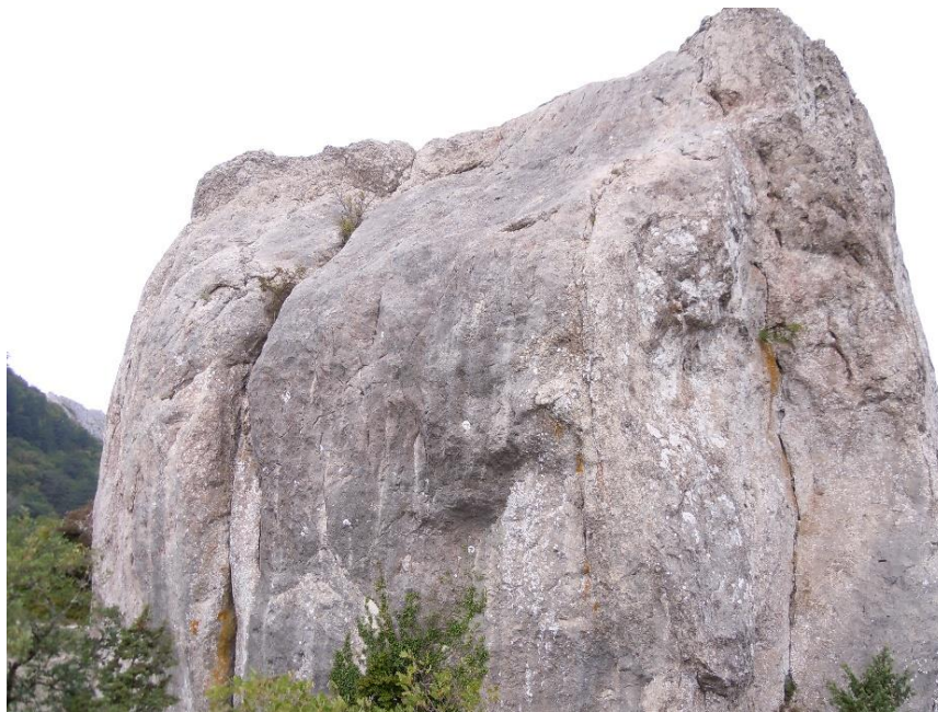
Рис. 3. Вертикальные трещины разгрузки в небольшом известняковом блоке – фактор, предопределяющий образование «Сахарных головок».
