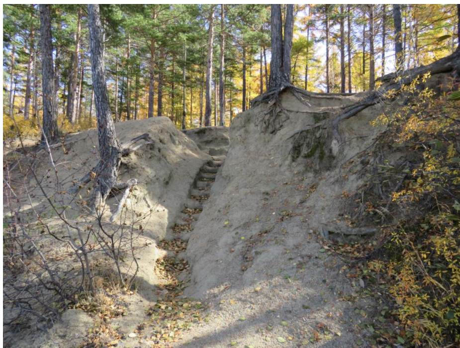
Рис. 4. Необорудованные сходы к воде.
