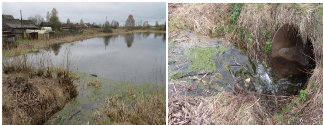
Рис. 3. Вид на пруд с плотины — слева, справа — водопропускное сооружение в теле плотины.
