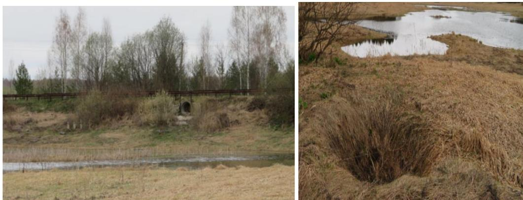
Рис. 6. Слева - Вид на плотину и водопропускное сооружение со стороны пруда; справа — карстовые воронки на южном берегу пруда.
